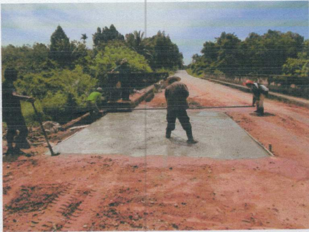
ภาพถ่ายแสดงขณะดำเนินการเทคอนกรีตพร้อมปรับระดับ
