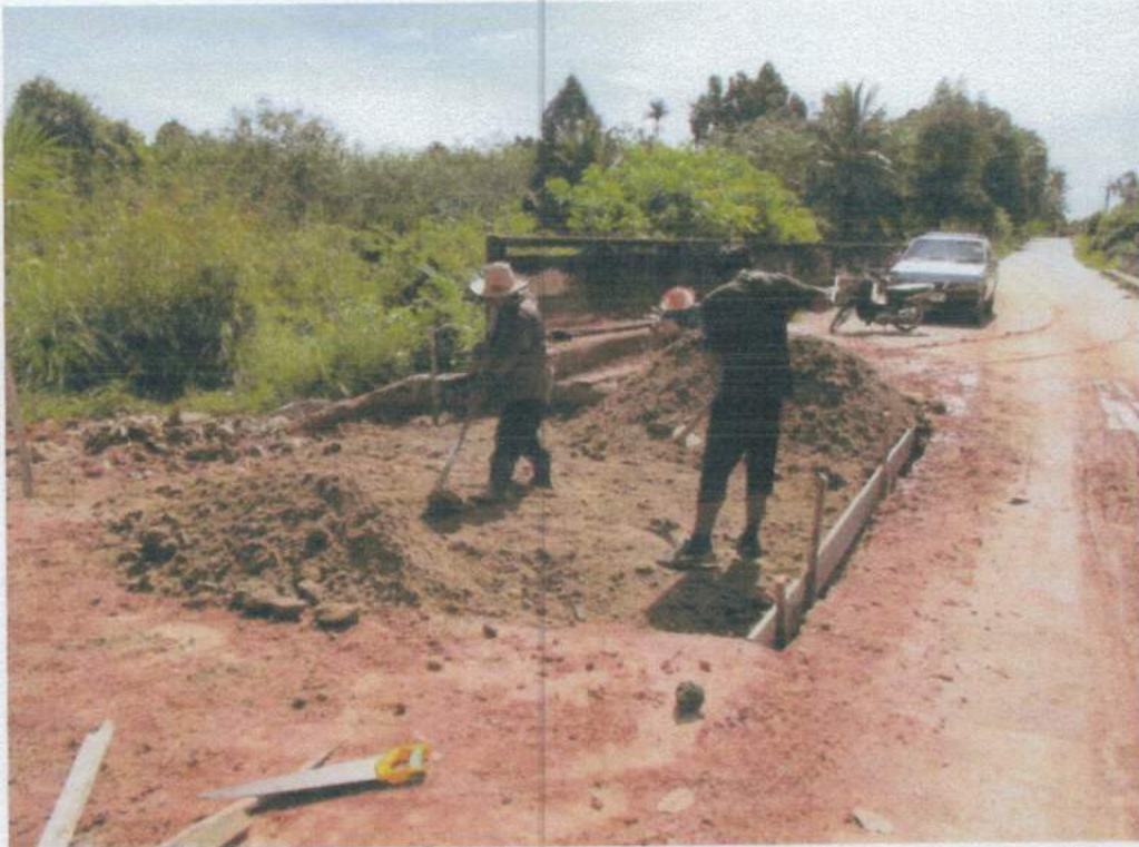
ภาพถ่ายแสดงขณะดำเนินการประกอบและติดตั้งไม้แบบ ไม้คร่า ลงเหล็กตะแกรง
