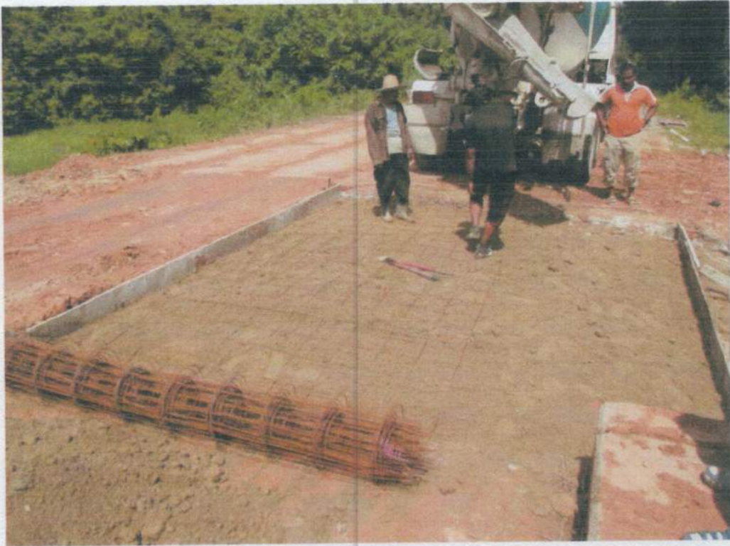
ภาพถ่ายแสดงขณะดำเนินการ สดเหล็กตะแกรงพร้อมเทคอนกรีต
