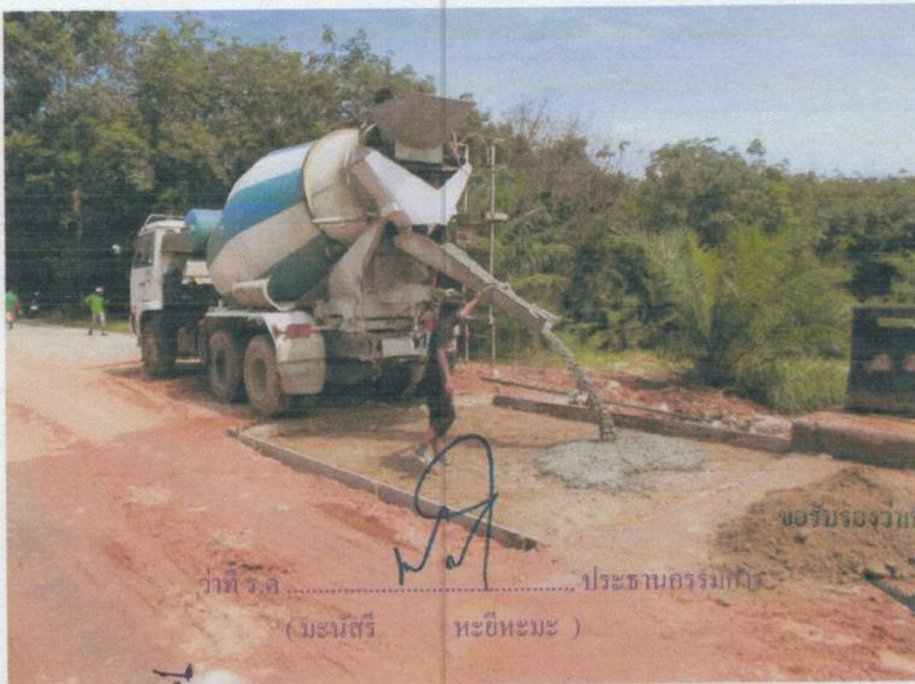
ภาพถ่ายแสดงขณะดำเนินการ สดเหล็กตะแกรงพร้อมเทคอนกรีต
