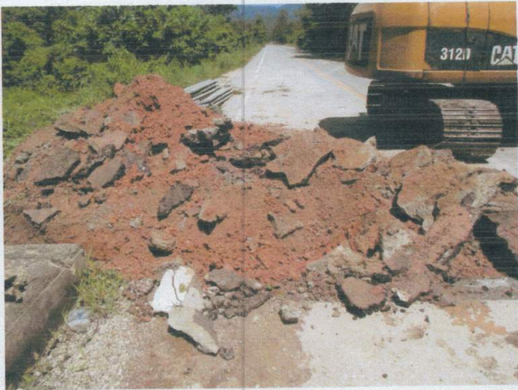
ภาพถ่ายแสดงขณะดำเนินการขุดดินคอสะพาน
