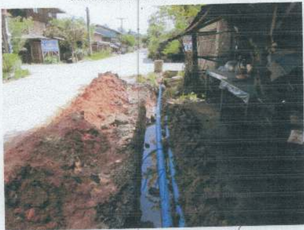
ภาพถ่ายแสดงขณะดำเนินการประกอบและติดตั้งท่อประปา
