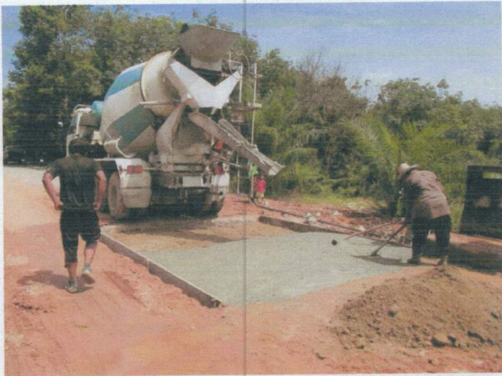
ภาพถ่ายแสดงขณะดำเนินการเทคอนกรีต
